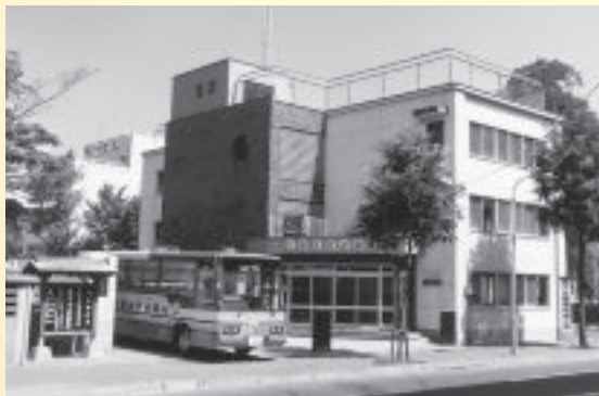
木造から鉄筋コンクリート造となった札幌明照幼稚園
