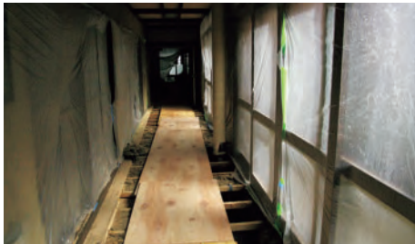
北側へ続く廊下
